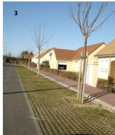
1 et 2) Parkings en « terre / pierre » 3) Parking en dalles gazon renforcées 4 et 5) Noues végétalisées (espaces verts en creux collectant les eaux pluviales)
