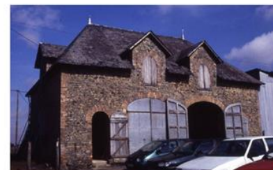
La maison avant travaux, avec sa charpente neuve reprenant le volume initial.
