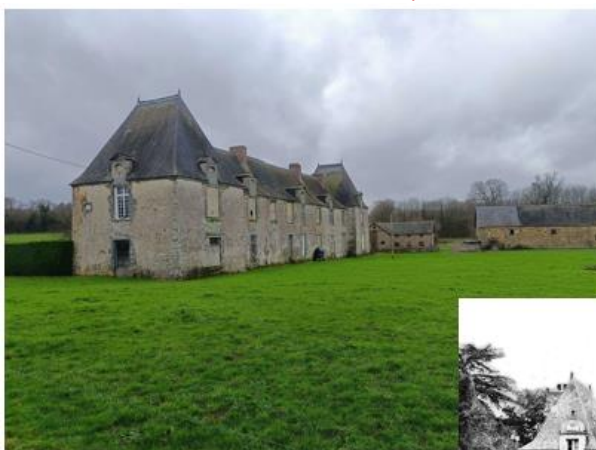
Château de la Grande Garenne
