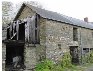
Le corps de ferme avant travaux
