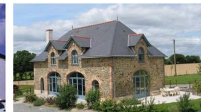
La grange après travaux à la volumétrie riche avec ses lucarnes gerbières. © Ad Hoc architecture Nantes
