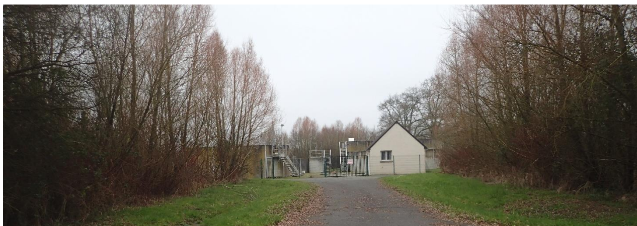
Photo 1 : Station d'épuration de Soudan
